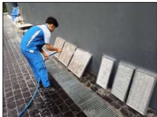
ภาพที่ 4 กิจกรรมทำความสะอาดระบบปรับอากาศ
