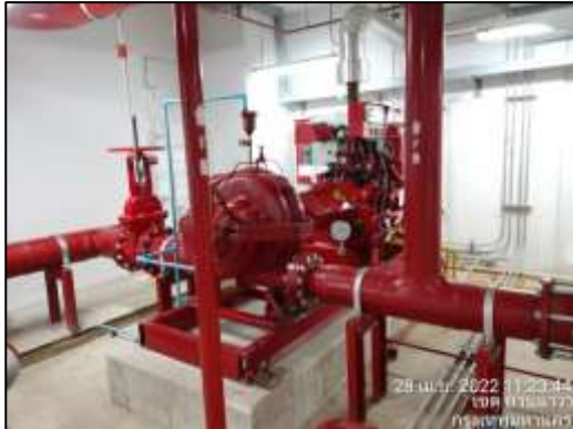
ภาพที่ 56 (ต่อ) ถังสำรองน้ำและปั้มน้ำดับเพลิง
