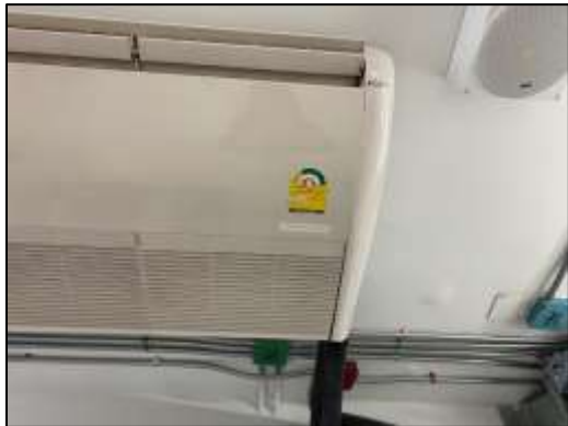
ภาพที่ 5 ระบบปรับอากาศที่มีฉลากประหยัดไฟเบอร์ 5
