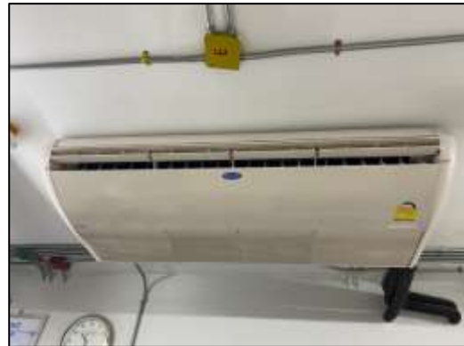
ภาพที่ 5 ระบบปรับอากาศที่มีฉลากประหยัดไฟเบอร์ 5
