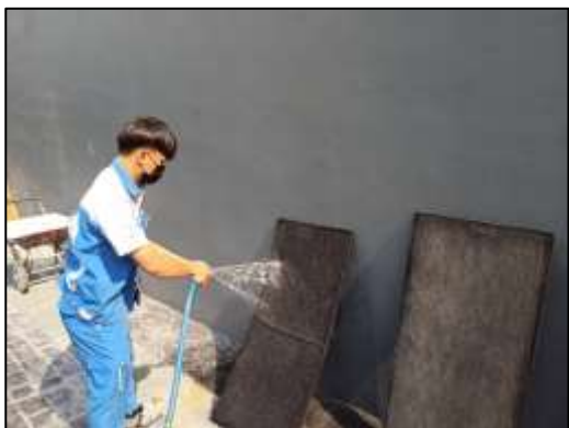
ภาพที่ 4 กิจกรรมทำความสะอาดระบบปรับอากาศ
